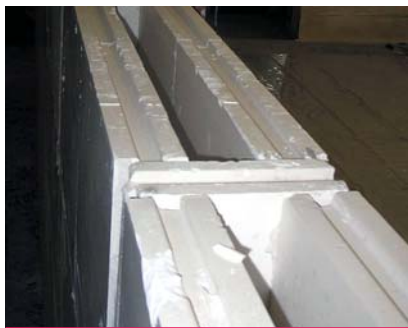
Fot. 1. Przegroda ogniowa z bloków MultiGips o odporności ogniowej EI 240 do wysokości 7,5 m
