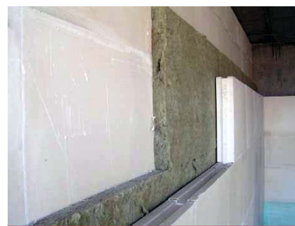
Ściana warstwowa MultiGips w trakcie montażu
